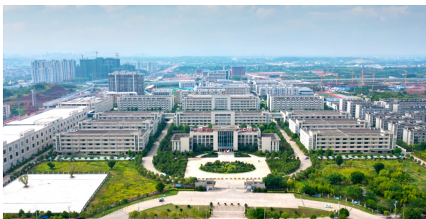
江西曼妮芬工业园区实景
